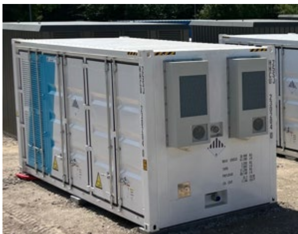
Figur 1-7 Eksempel på energiopbevaring med batteri i containerløsning.
