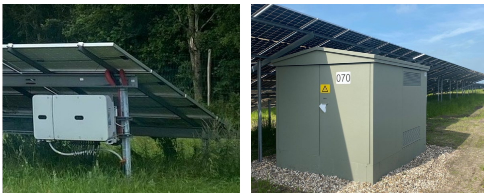
Figur 1-5 Eksempel på inverter (t.v.) og transformer (t.h.).
